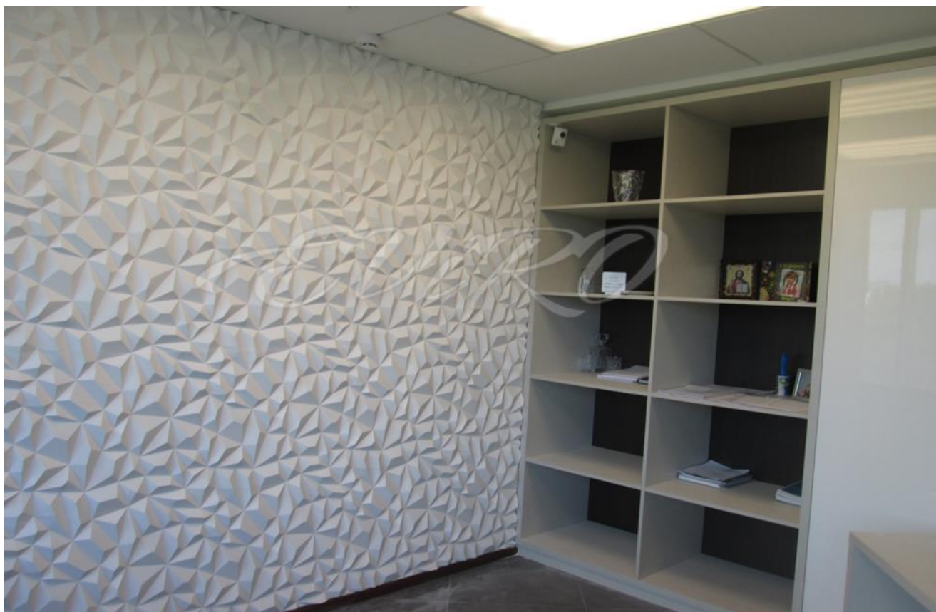
Рис. 7 Выполненный монтаж Гипсовых 3d панелей ЕВиРО
